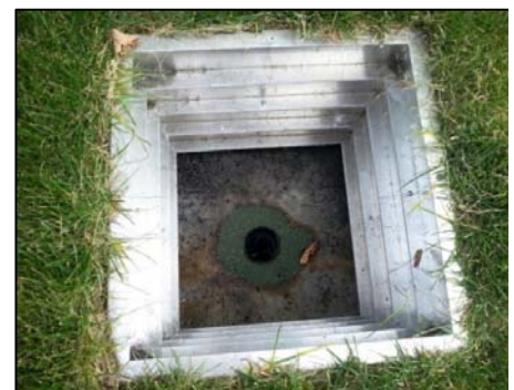
Fertig eingebauter Ablaufkörper mit umgebendem Schacht
