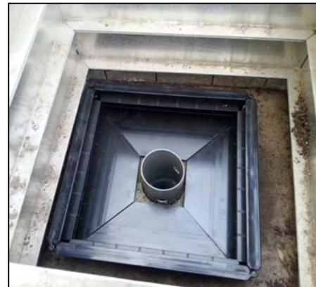
Fertiger Drosselablauf mit umgebender Optigrün-SKL Kiesleiste
