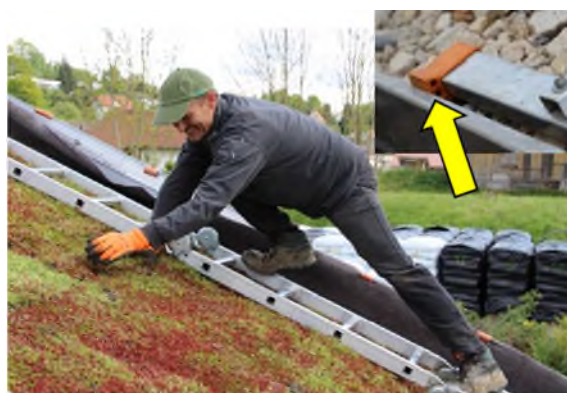
Leiter ggfs. am Überstand des Traufprofils anlegen
