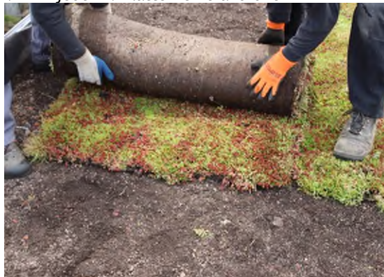
Vegetationsmatten über den Zinken auslegen
