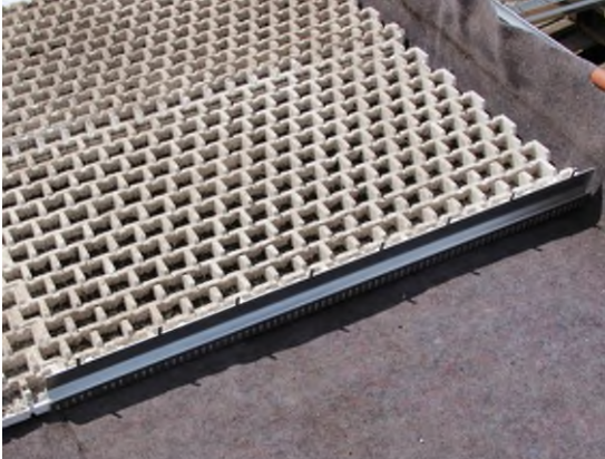
VFL ohne Fuge stumpf aneinander stoßen
