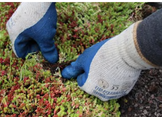
Zinken von oben durch die Gewebeeinlage drücken
