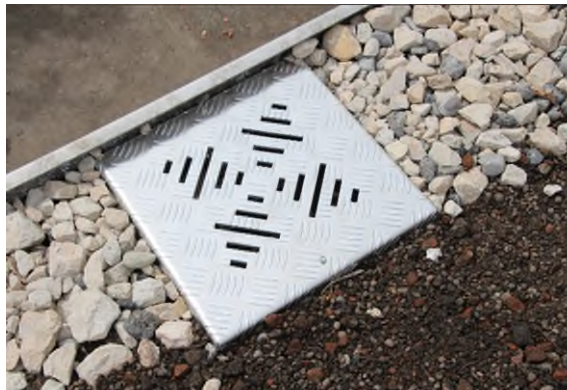
Unterer Kiesstreifen auf Schachtbreite abstimmen
