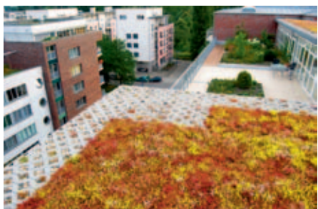
(6) So ist es richtig – Rasengittersteine im Rand- und Eckbereich bei windexponierten Lagen
