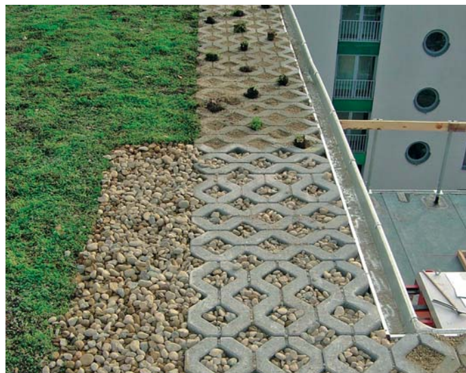
Mögliche Maßnahmen zur Lage- und Verwehsicherheit: Rasengittersteine und Vegetationsmatten
